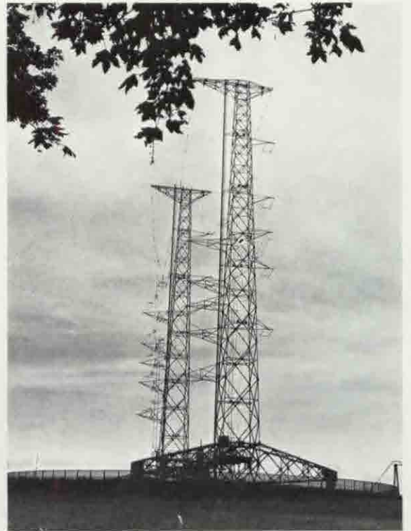
Mit dem Bau der Kurzwellen-Antenne in Sottens, die sich in alle Richtungen drehen lässt, ist eine neue Generation von Antennen eingeleitet worden. Es ist dies die grösste Drehstandantenne der Welt.
