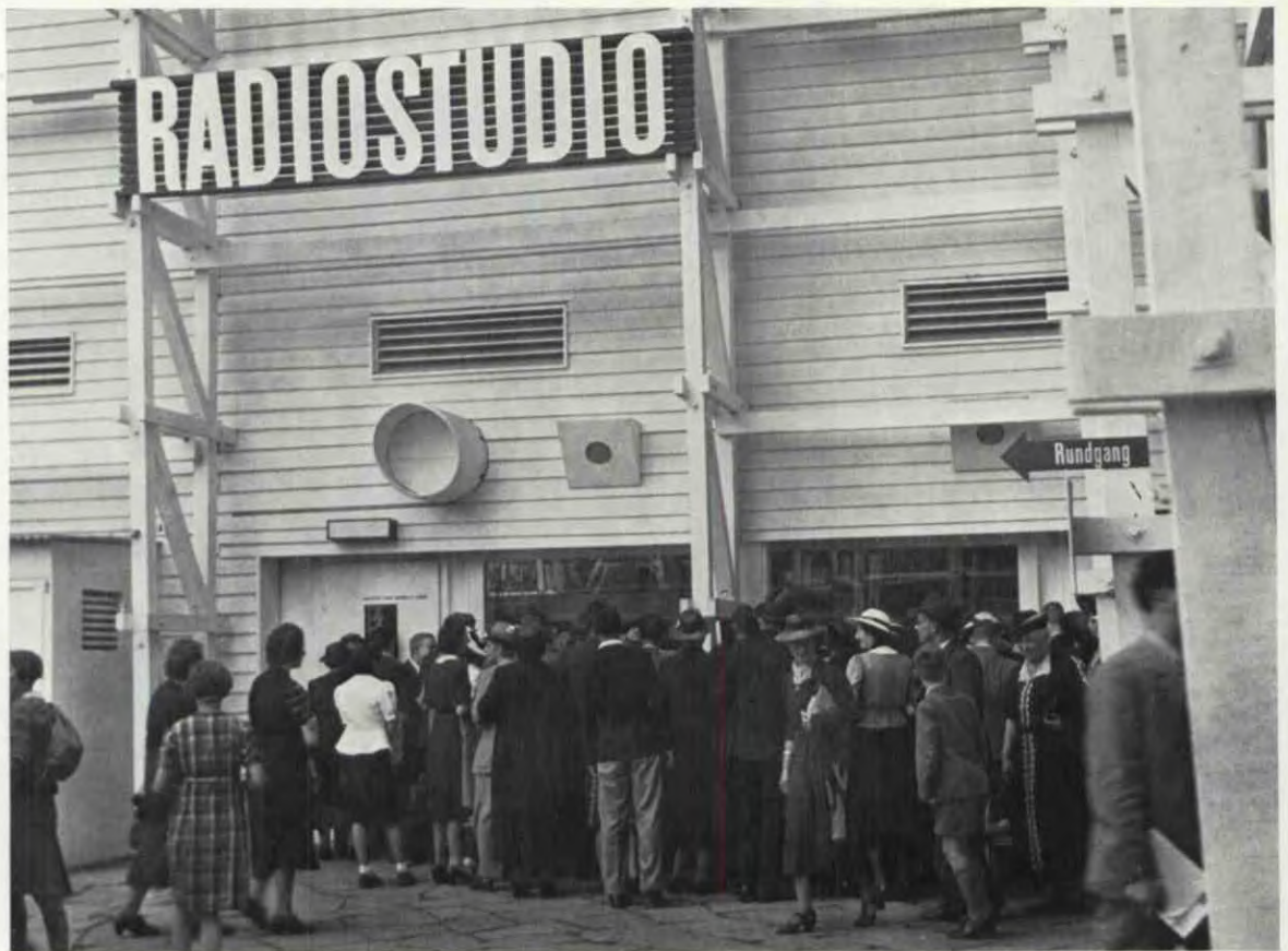
Des studios installés dans le cadre d'expositions ne sont rien de nouveau, ni pour la SSR, ni pour le public. Voici le studio de radio à l'Exposition nationale de 1939 à Zurich...
